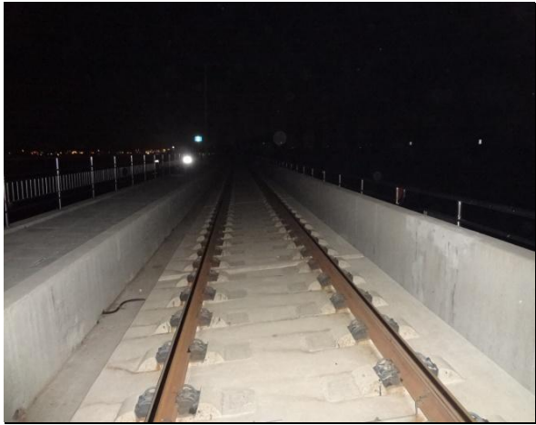
교량 상부 전경
