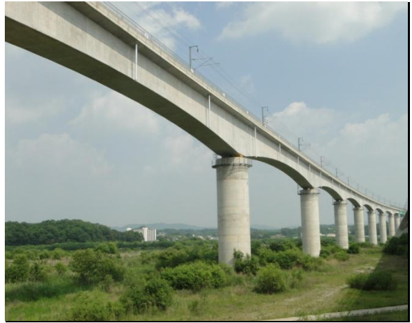
교량 측면 전경
